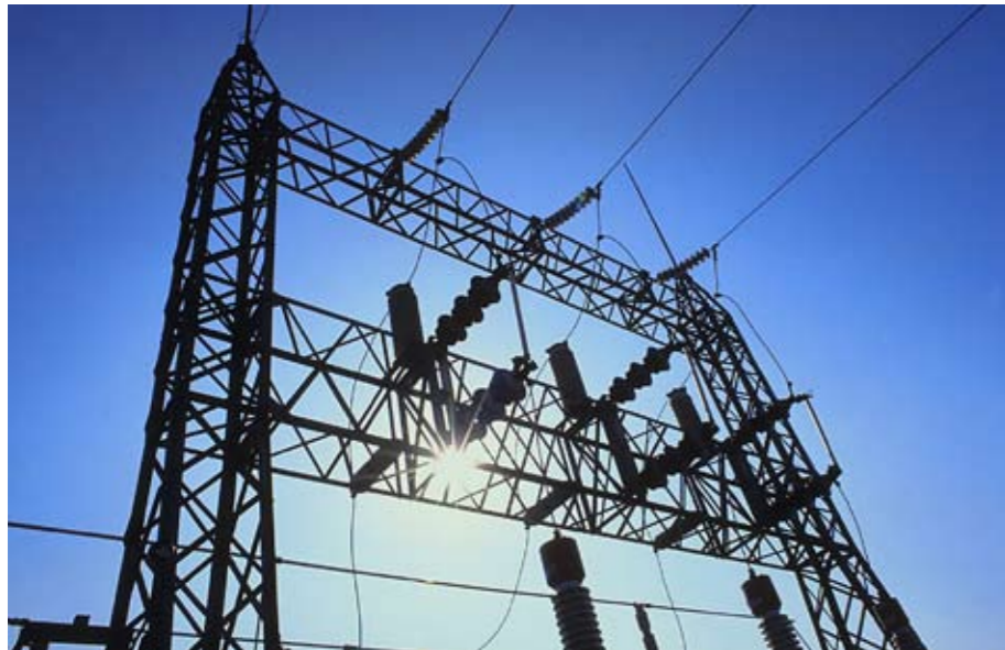
Wenn die Stromversorgung ausfällt, schlägt die Stunde von Elinex
